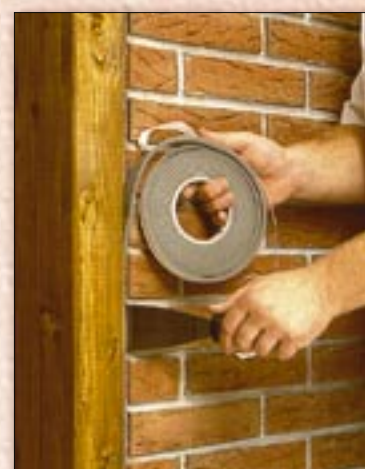
Układanie taśmy przy ościeżu
